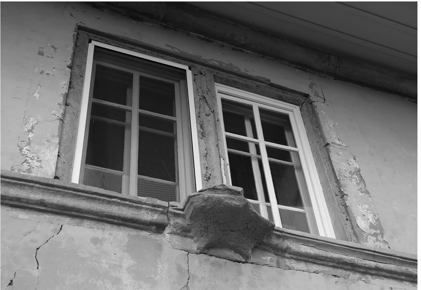
Détail d'une fenêtre de la façade ouest, avant restauration
