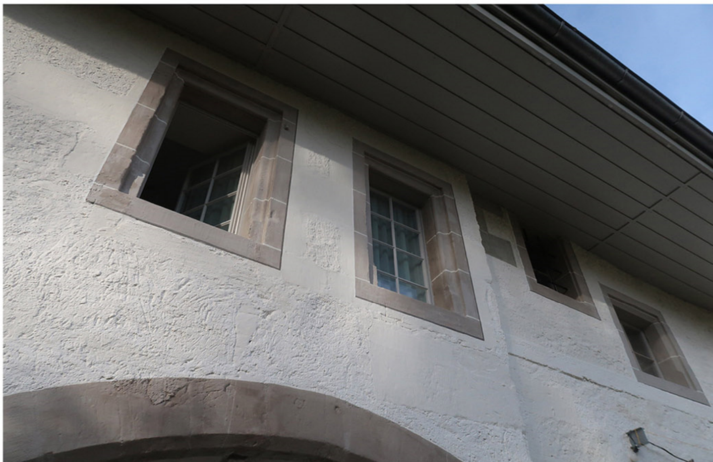
Façade est, restauration d'encadrements de fenêtres avec restitution du décor peint du 17ème siècle
