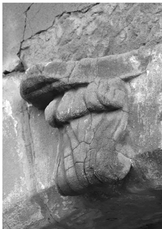
Détail d'une clef d'arc, façade ouest
