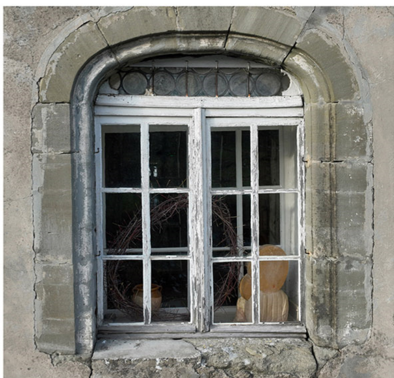
Fenêtre centrale de la façade sud, 1er étage, avant restauration
