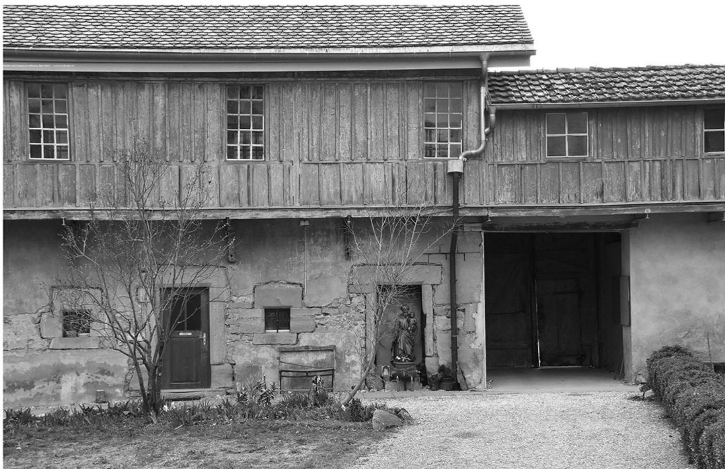
Hôtellerie, façade est avant la restauration
