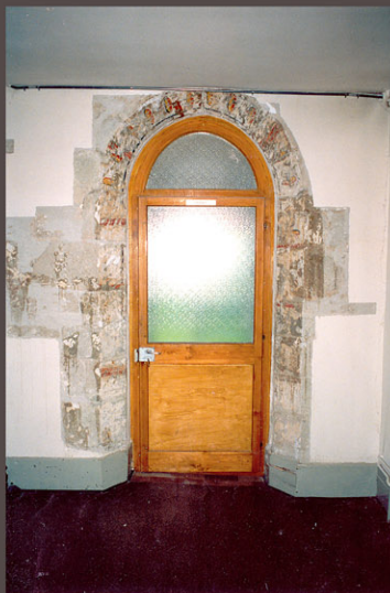
Fenêtre sud de la nef avant travaux
