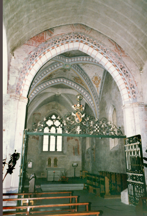
La grille du sanctuaire et l'arc triomphal avant restauration
