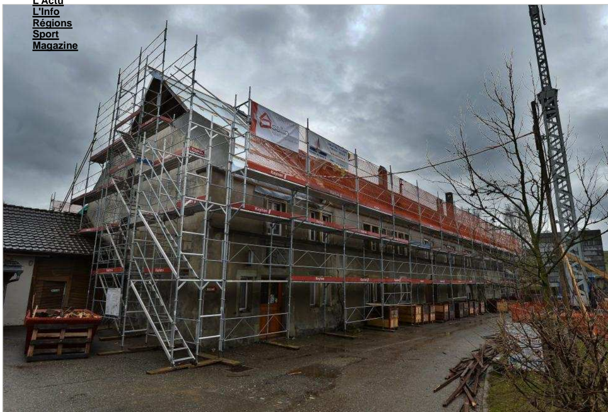
Les travaux, en cours, devraient s'achever cet été. Alain Wicht
