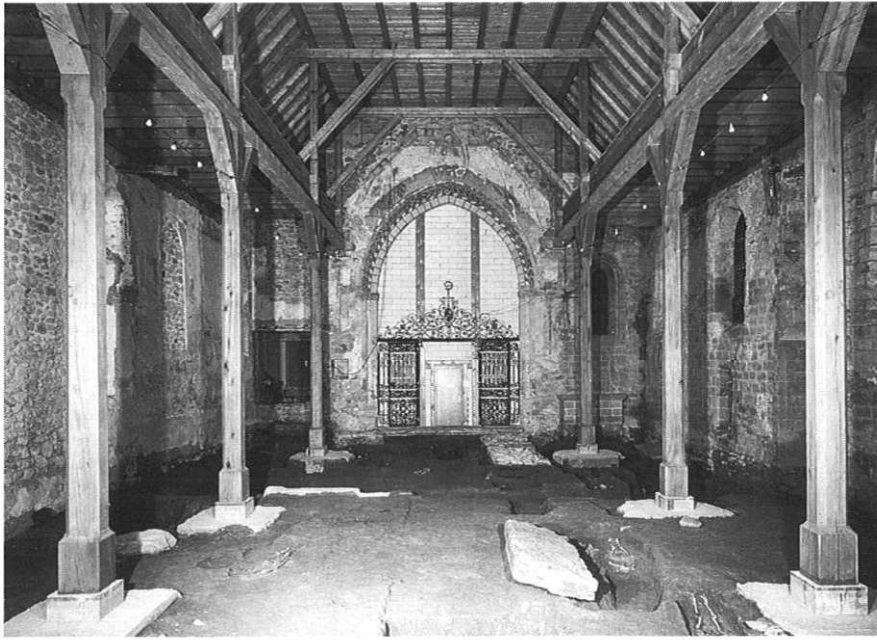
Fig. 15 La nef et l'arc triomphal en 1993 après la restitution des poteaux de bois selon les dispositions du milieu du XIV e siècle, reprises au XV e siècle. Deux des poteaux datent de 1452, les six autres sont des copies
