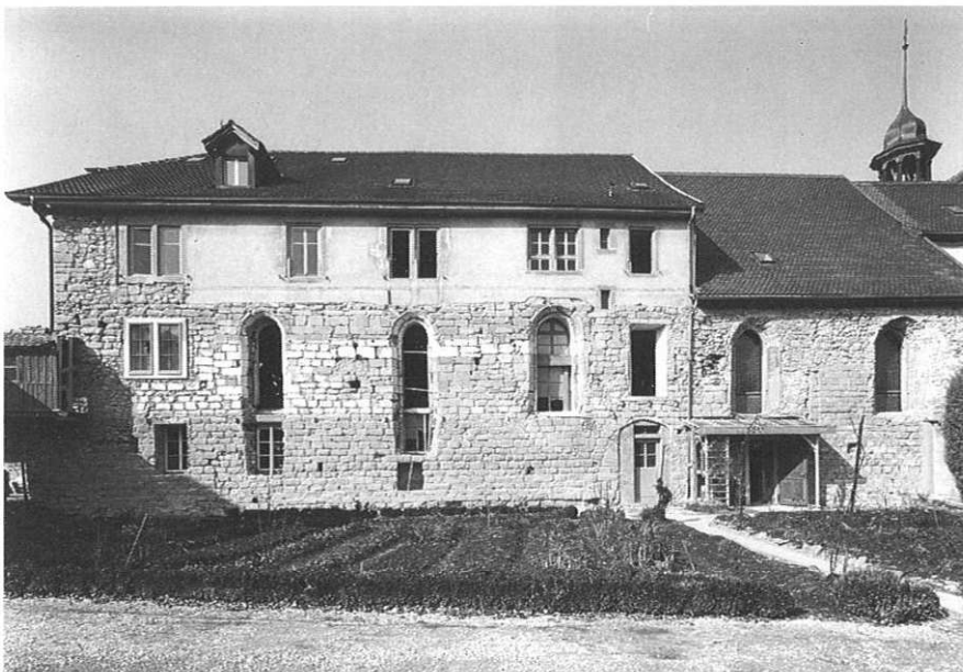
Fig. 16 Mur sud de la nef en cours de restauration. Les trois fenêtres en arc brisé de gauche datent de 1346, les deux autres de 1724-1726 environ. L'étage supérieur et la plupart des fenêtres rectangulaires remontent à l'installation de l'hôtellerie dans la nef en 1873
