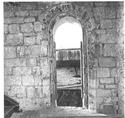
Fig. 19 Fenêtre du mur sud de la nef; les blocs de son encadrement ont été calés par les maçons à l'aide de coins de bois taillés dans des arbres abattus, d'après la dendrochronologie, en automne-hiver 1345-1346. Traces des décors peints des XIV e et XVI e siècles
