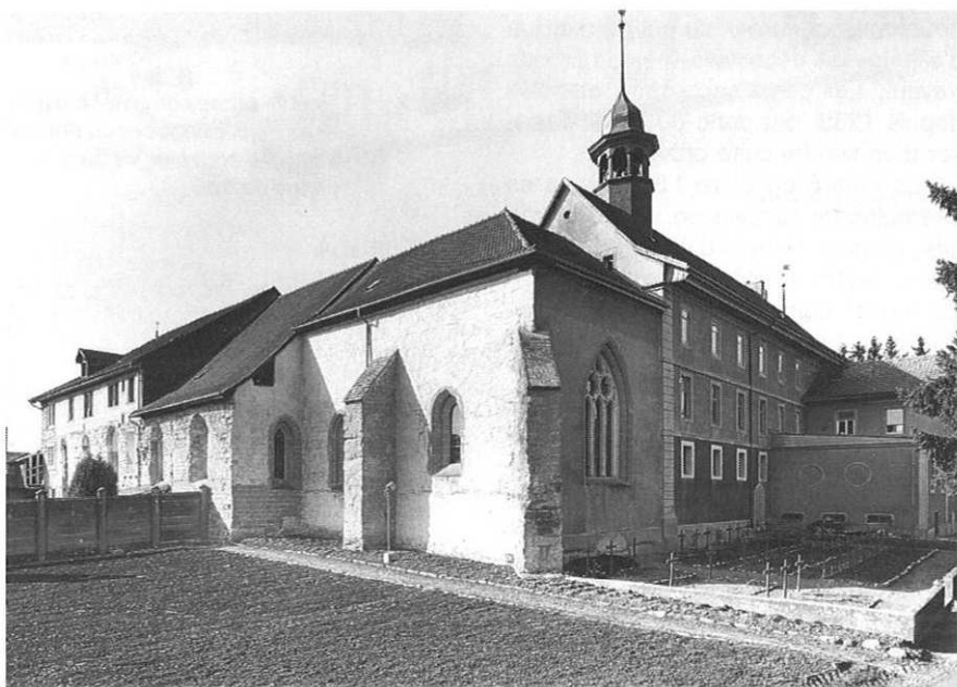
Fig. 8 Sanctuaire et nef de l'église consacrée en 1346. A droite, le clocher surmonte le chœur des religieuses établi perpendiculairement au sanctuaire en 1724-1726
