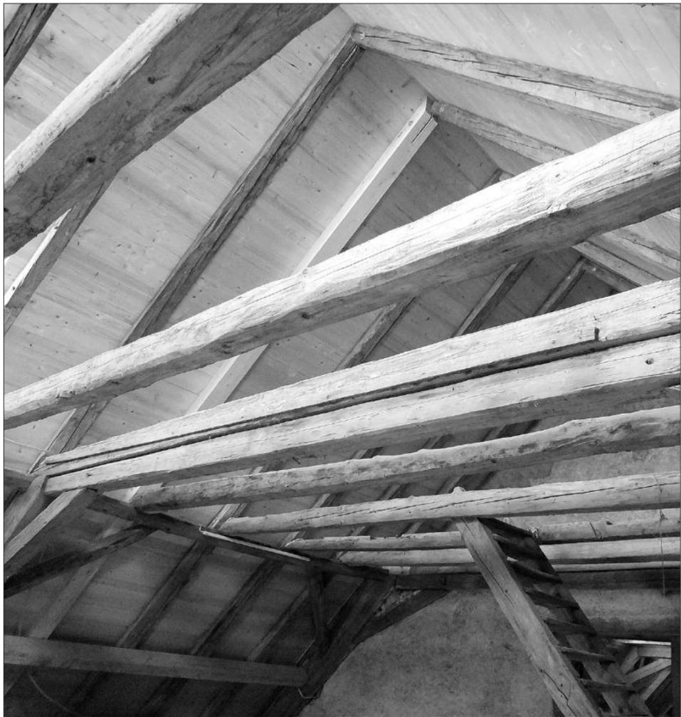
La plupart de poutres existantes ont pu être réutilisées, pour redonner au toit son inclinaison originelle.
