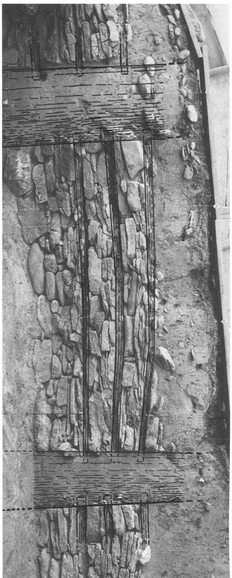
Fig. 5. - Vue du mur de refend nord de la tour sud (les fils sont distants de 1 m). Restitution graphique des éléments en bois
